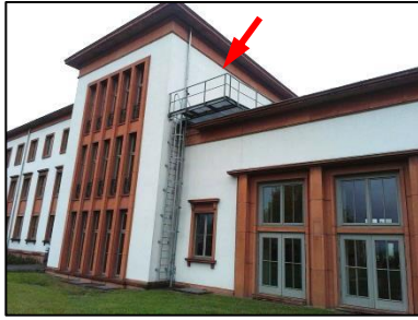
Bild 5: Fluchtweg für den Raum 1.308, von der Elbseite aus gesehen. Die Fenster unten rechts zu ebener Erde gehören zur Bibliothek.
