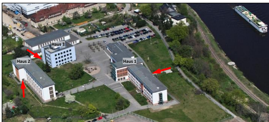
Bild 1: Luftbild des Campus, Lage der Fluchttüren (rote Pfeile).
