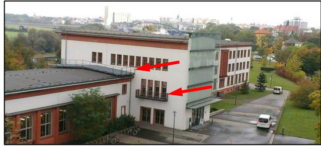
Bild 6: Fluchtweg für den Raum 1.308 (oben) und 1.208 (darunter). Vom balkonartigen Gebilde am Raum 1.208 kann eine dort vorhandene Leiter nach unten angelegt werden.
